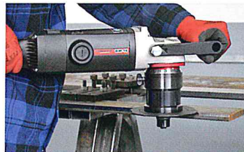
板金(スチール)の開先加工
